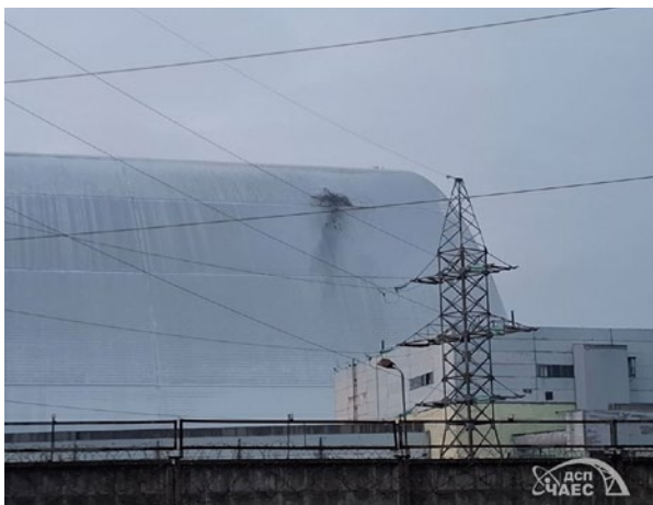
Einschlagstelle der Drohne in das NSC
