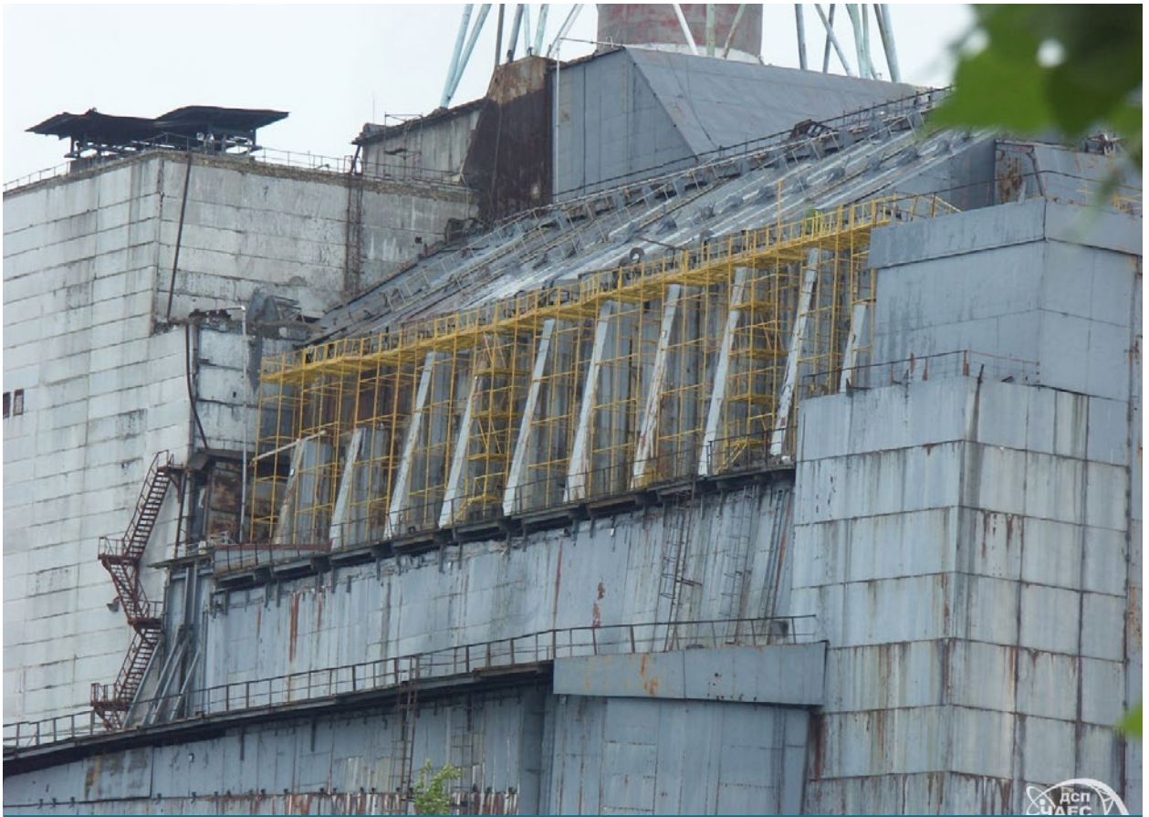
Stabilisierter Sarkophag
