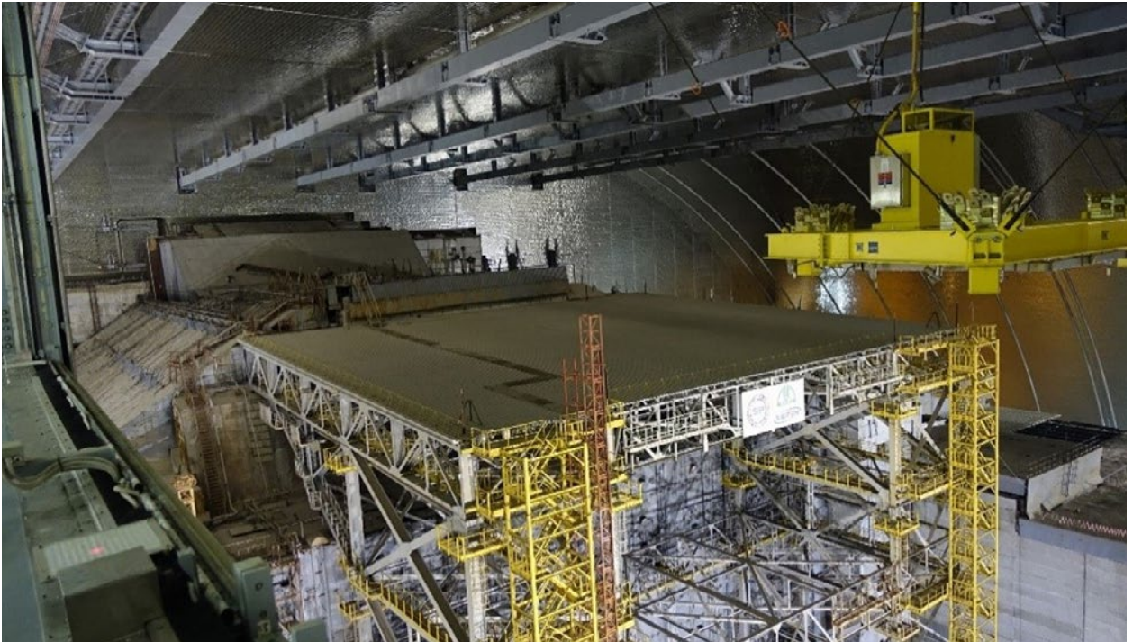
Blick unter das NSC mit dem Sarkophag und dessen Stabilisierung
