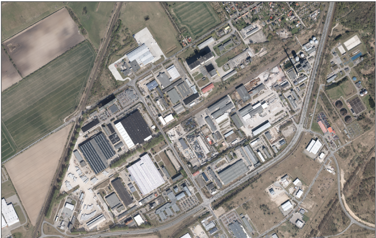
Abbildung 17: Luftbild Gewerbegebiet „Schwerin Süd“
