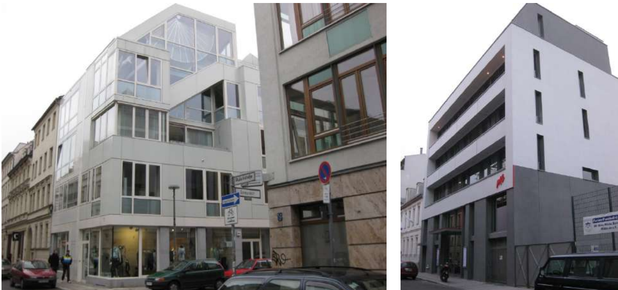
Abbildung 11: Neubauten in der Mulackstraße und Auguststraße
